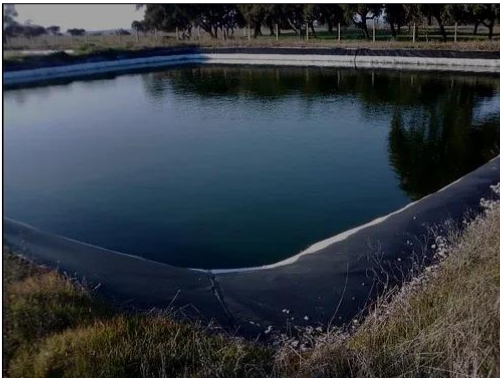
Figura 08: Lagoas facultativas se utilizam de um tratamento biológico sem uso de produtos químicos Fonte: LogicAmbiental, 2016.
