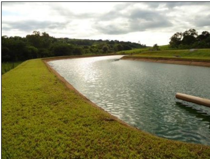
Figura 07: Exemplo de lagoa facultativa Fonte: LogicAmbiental, 2016.
